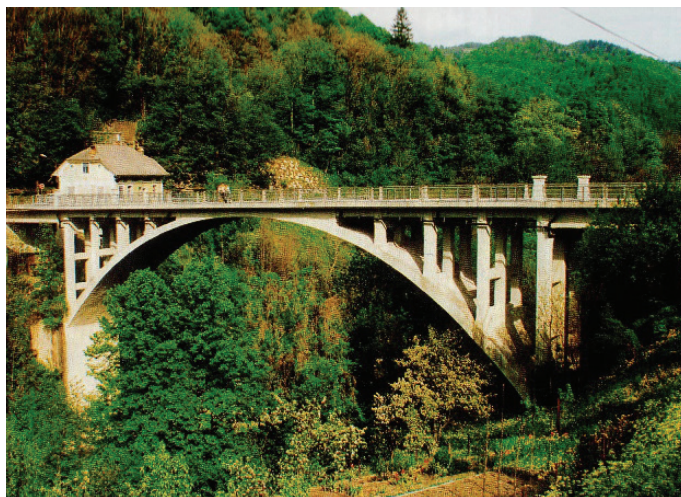
Slika 9 • Armiranobetonski cestni most čez Idrijco pri Mostu na Soči. Napredek pri razvoju oblike v primerjavi s kamnitimi mostovi je viden. Foto: Bogdan Kladnik
