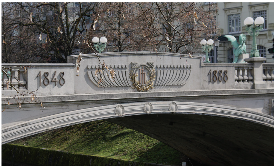
Sliki 13 • Zmajski most v Ljubljani iz leta 1901, ki je iz armiranega betona po sistemu Melan in ima čudovito secesijsko arhitektonsko podobo. Foto: Gorazd Humar
